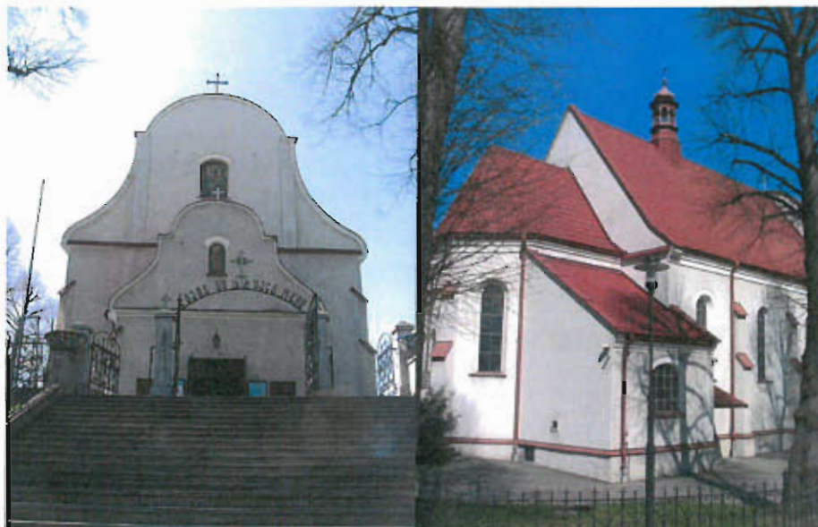
Fot. nr 3 Kościół p.w. Matki Bożej Nieustającej Pomocy w Łysej Górze
